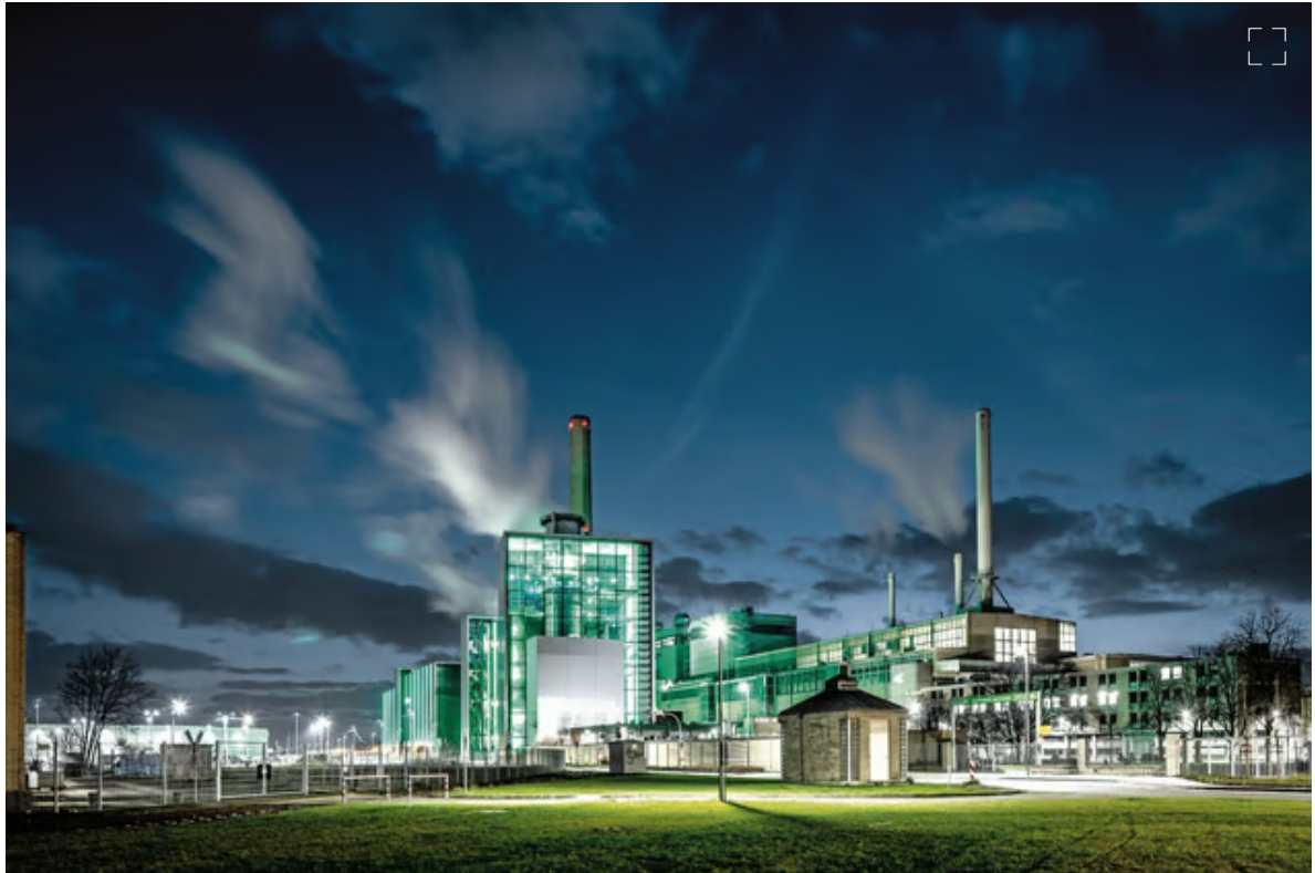
Düsseldorfer Heizkraftwerk: Unklare Auslegung der Vorgaben. Foto: Paul Langrock/laif
