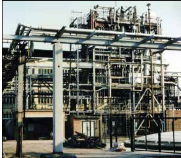
Filitoxanlage, um 1993: Das Chemische Kombinat Bitterfeld (CKB) produziert zu DDR-Zeiten „Filitox“, ein Insektizid. Miltitz Aromatics baut die Anlage zur Phasentransferanlage um.
