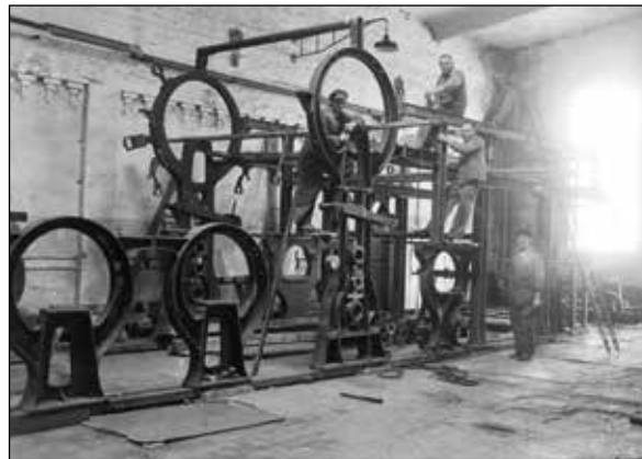
Montage der Papiermaschine
