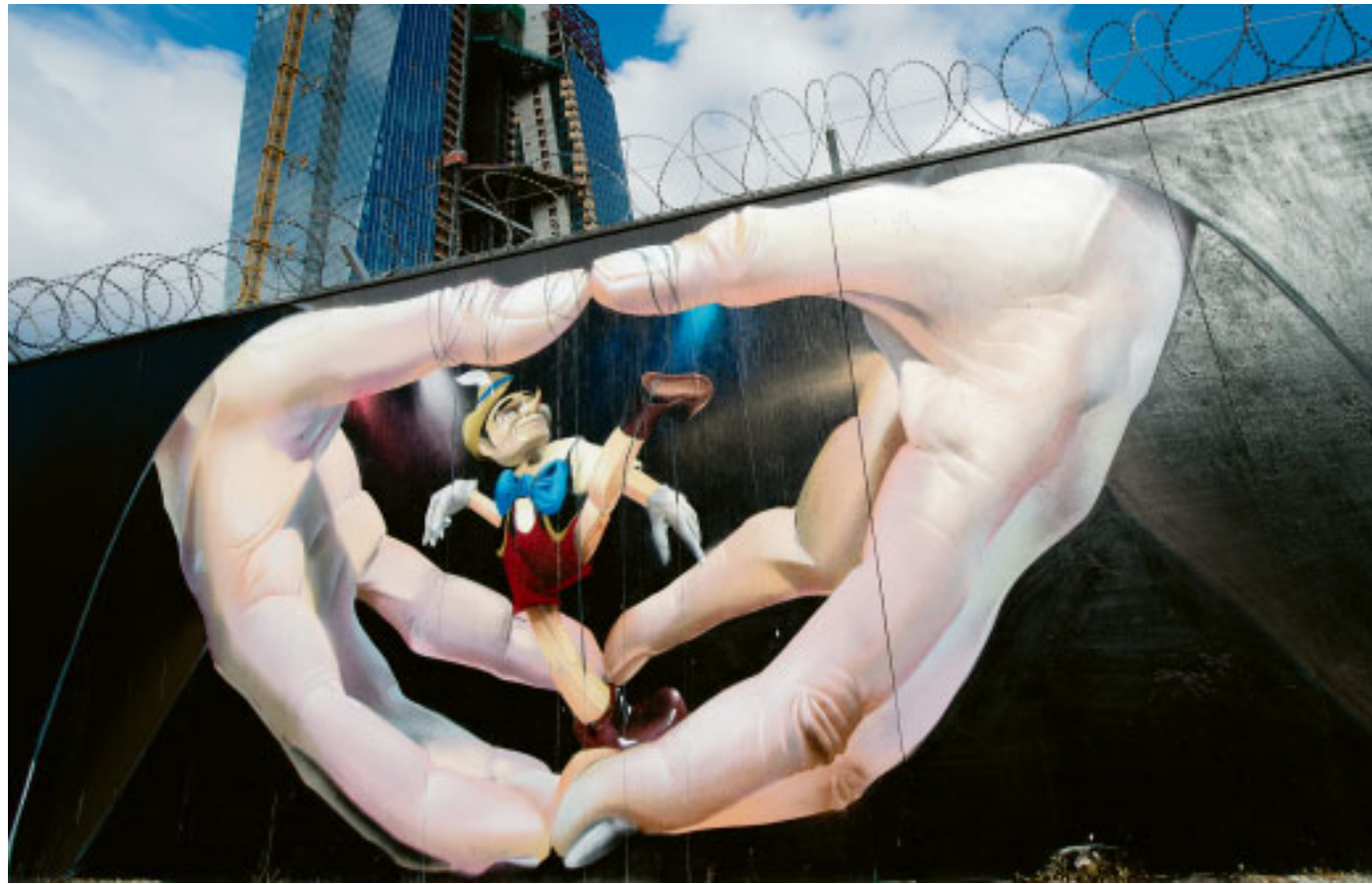
Die EZB-Großbaustelle: Am Zaun hat ein Graffiti-Künstler einen Pinocchio gesprüht.
